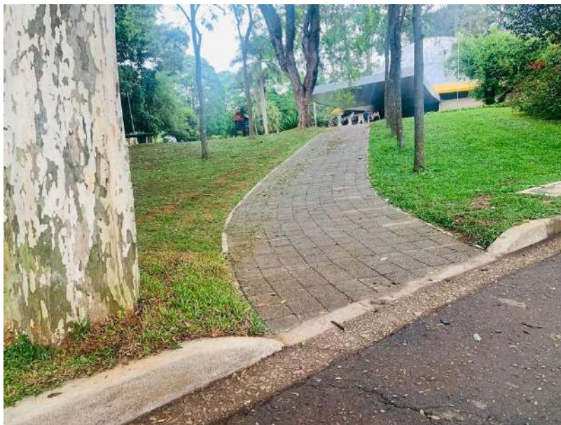
Figura 56: Acesso ao planetário, readequado com piso permeável acessível.
