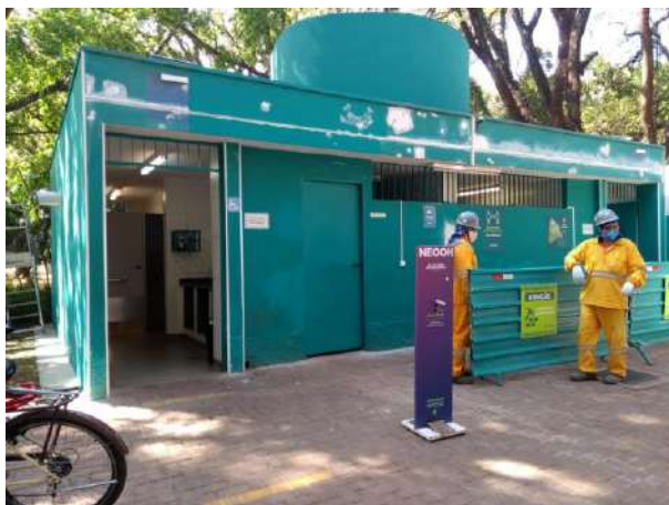
Figura 63: Reforma dos sanitários
