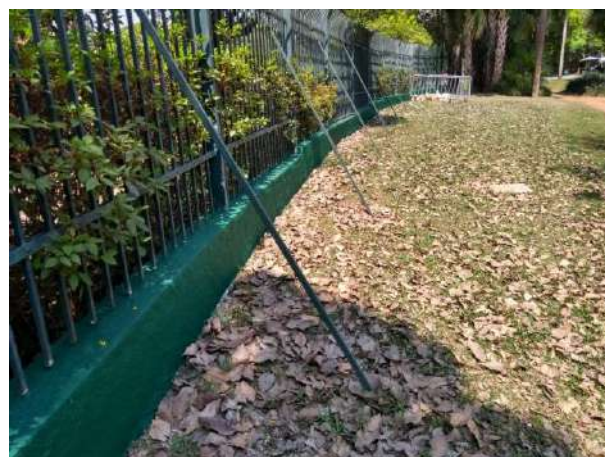
Figura 74: Pintura da área perimetral
