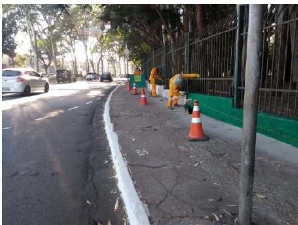
Figura 73: Pintura da área perimetral
