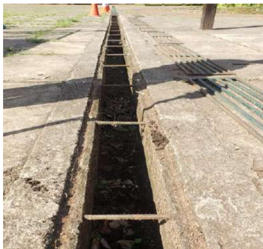
Figura 61: Limpeza de grelhas
