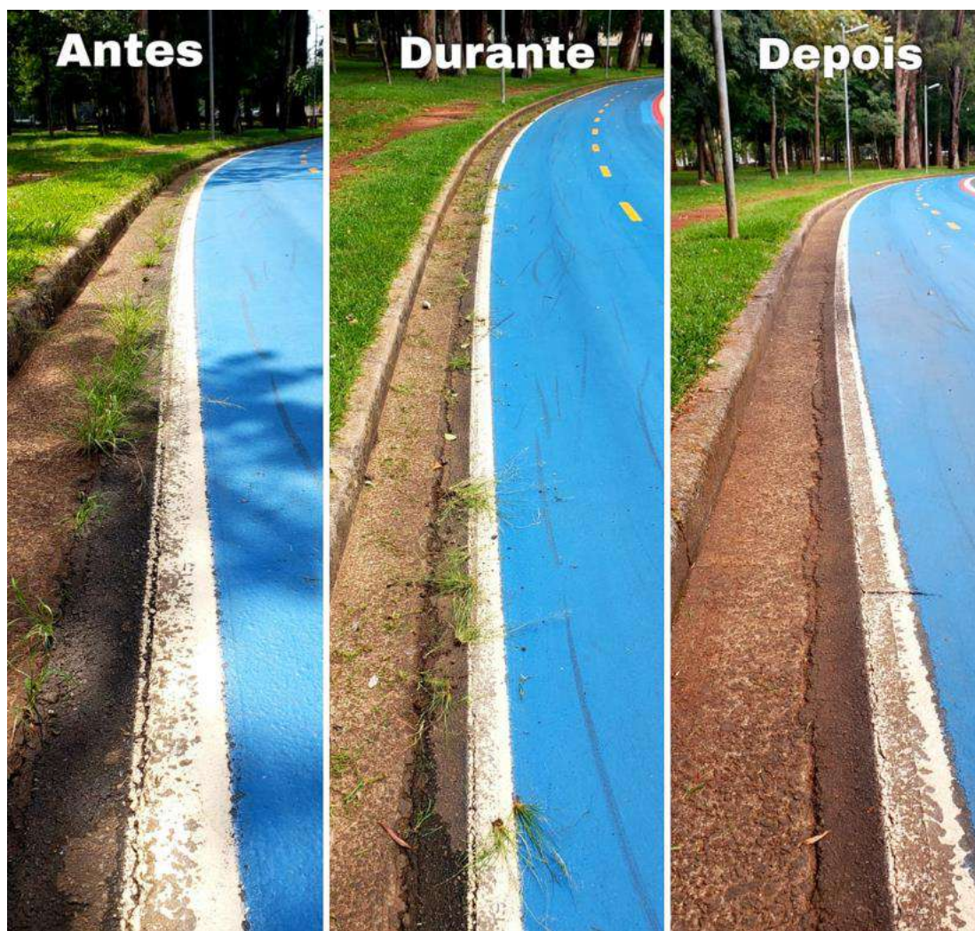
Figura 62: Despraguejamento de guias
