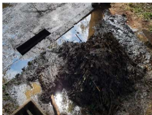
Figura 60: Limpeza de bocas de lobo
