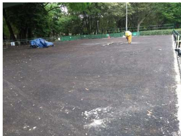
Figura 86: Quadra - Reforma do Piso
