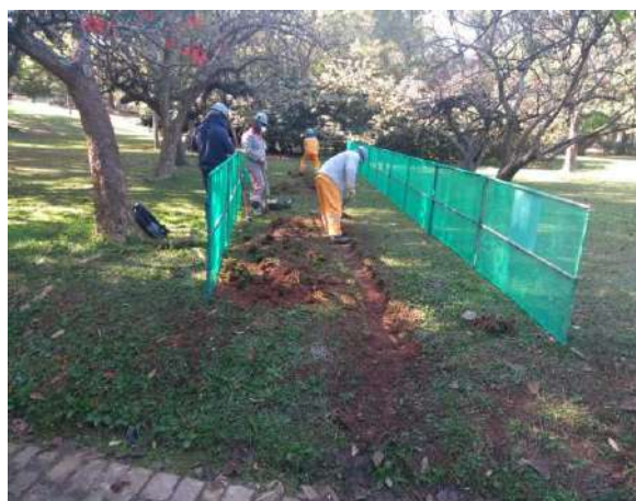
Figura 72: Drenagem Próximo a Ponte de Ferro
