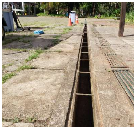
Figura 61: Limpeza de grelhas
