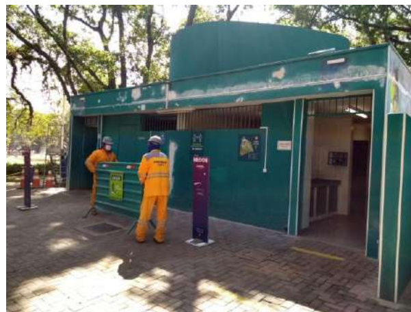
Figura 64: Reforma dos sanitários
