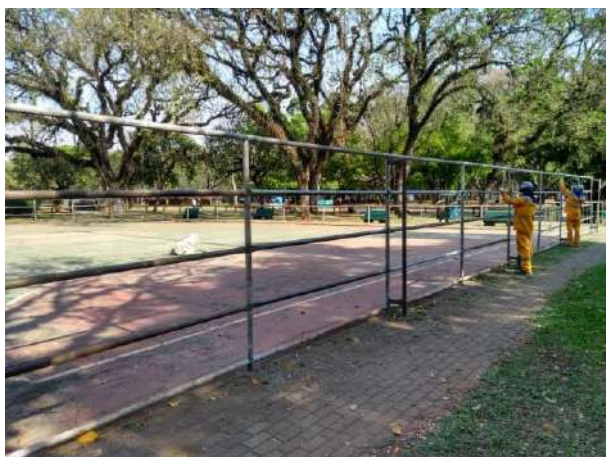
Figura 85: Quadra - Reforma dos Alambrados
